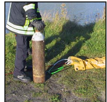
Befüllen der Sperre mit Druckluftflasche
